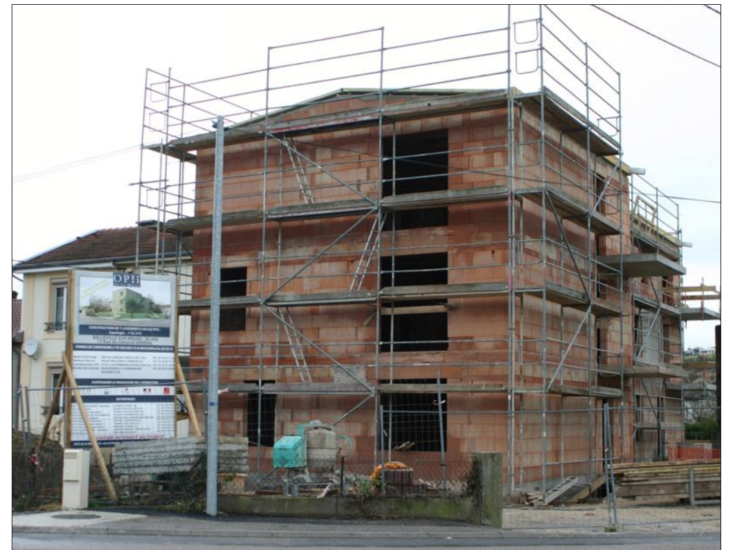
■ Les bâtiments sont en voie de finition.
