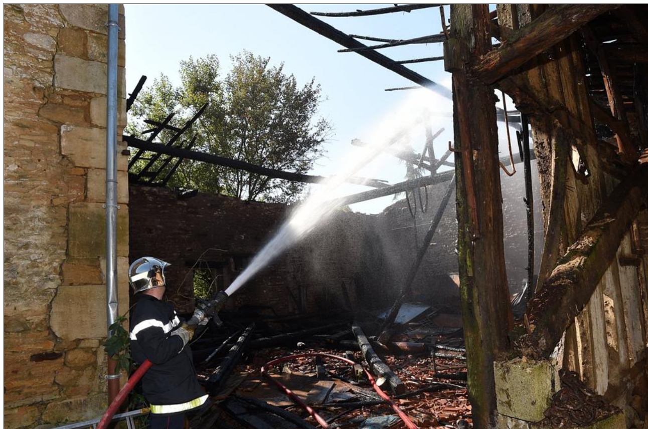
La grange et son contenu sont partis en fumée.
