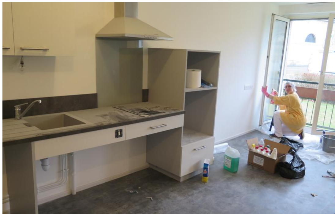
Ce T2 destiné à une personne à mobilité réduite est terminé. Il ne reste plus qu'à le nettoyer et à l'équiper de plaques chauffantes, et d'un four. Photo ER
