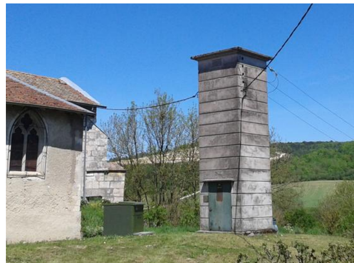
La « cabine haute » d'Ugny, présente sur cette photo avant la fin des travaux, a été démantelée, offrant une vue imprenable sur la vallée.
